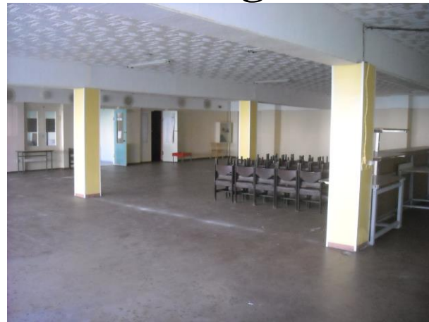
Kutsekooli sööklaruumid enne remonti
